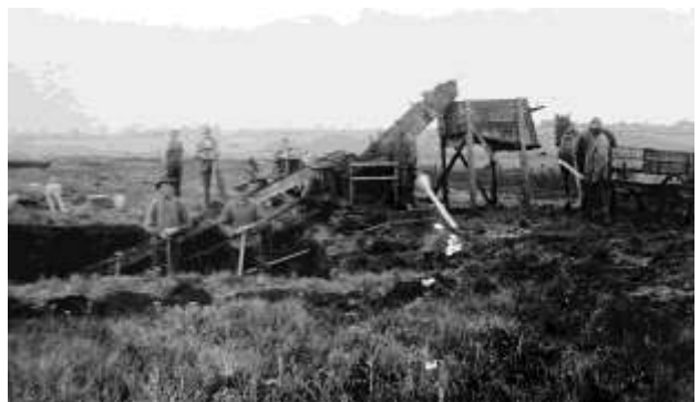
Midt i billedet ses August Sørensen ved pumpen til æltemaskinen. Selve materialet føres op af graven via et transportbånd. Fra æltemaskinen, der drives vha. en traktor, læsses det æltede materiale op i "dyndkarret". Til højre i billedet ses besten forspændt "dyndvognen", ca. 1950.
