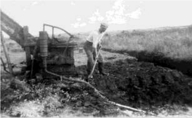
Pedersen, kaldet "Jens Støbr" graver tørvematerialet direkte op i æltemaskinen, der trækkes af en petroleumsmotor. Vandet pumpes op i æltemaskinen via en slange, Bendstrup Mose 1958.
